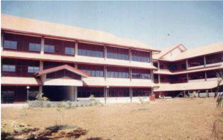
Gambar 1. Proses pembangunan gedung Fakultas Ilmu Kelautan dan Perikanan, Universitas Hasanuddin.
